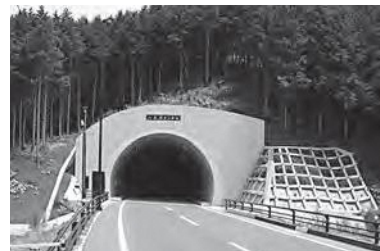
▲八木沢トンネル
