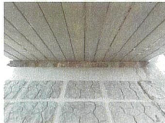
A2橋台護岸補修済
