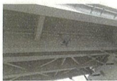
ドローンによる桁下の点検
