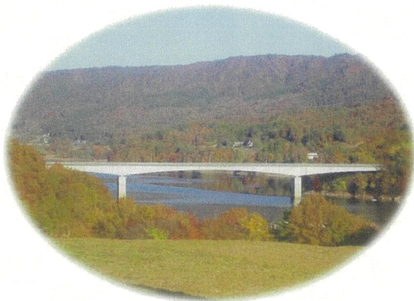
大倉大橋 (1989年竣工)
